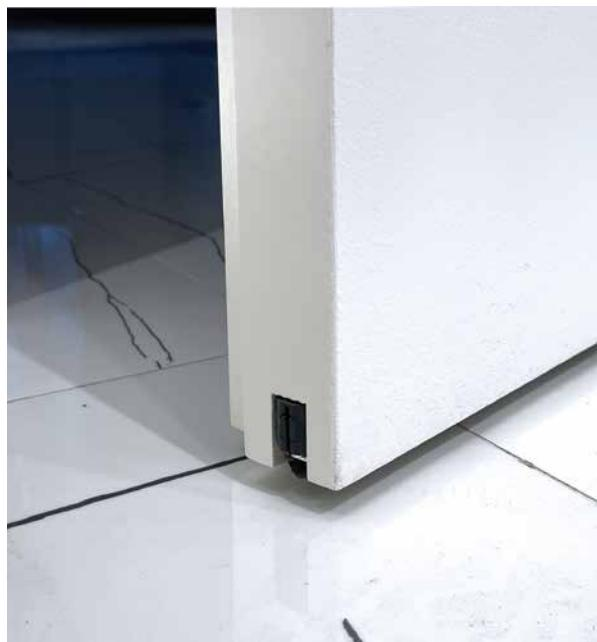
**Ispadajuća guma** - integrše se u donji kant krila vrata. Aktivira se pri zatvaranju i time poboljšava zvučnu i termo izolaciju sobnih vrata. U slučaju da vrata idu do plafona samoispadajuća guma se stavlja i u gornjoj zoni.
